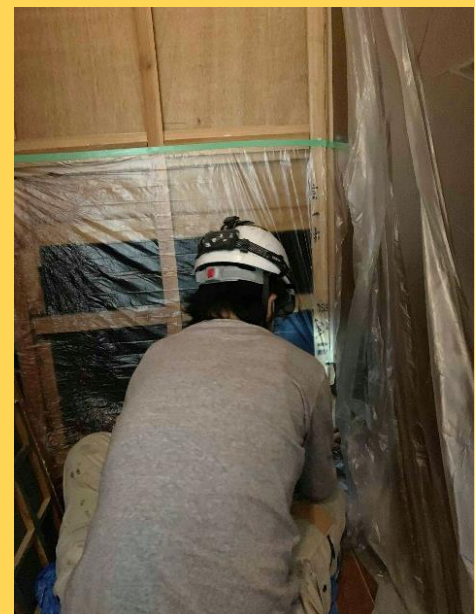
世田谷での養生作業の様子
