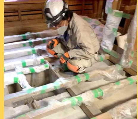
世田谷での床下作業 1
