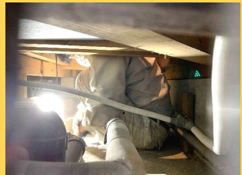
世田谷での床下作業 2
