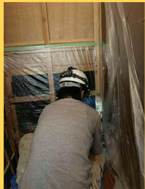
世田谷での養生作業の様子
