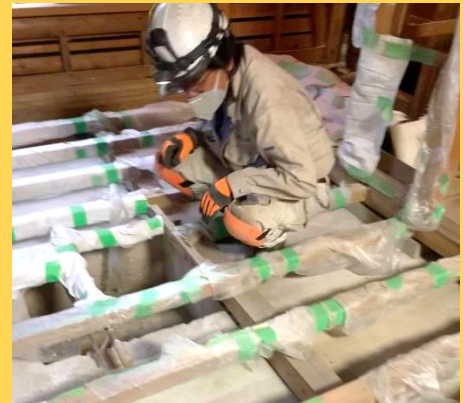
世田谷での床下作業 1
