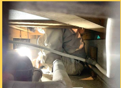
世田谷での床下作業 2
